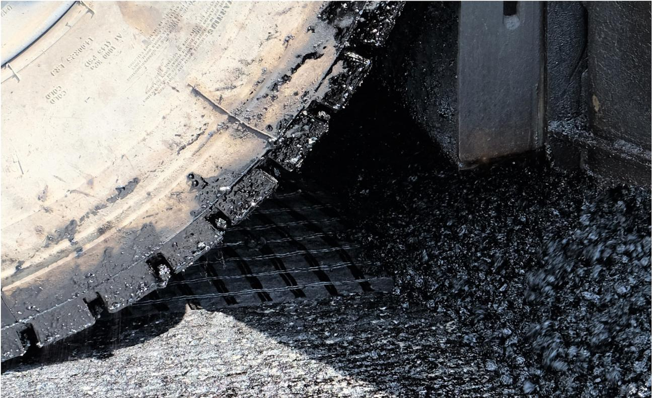
Einbau der Asphaltdeckschicht (SMA 11) auf das verlegte Asphaltbewehrungsgitter HaTelit G50
