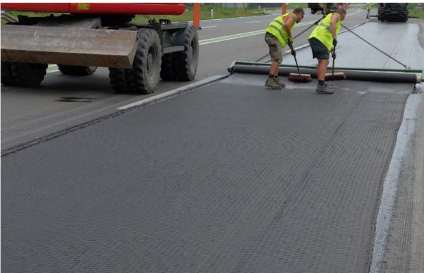
Verlegung der Asphaltbewehrung HaTelit G50 in die teilgebrochene Bitumenemulsion
