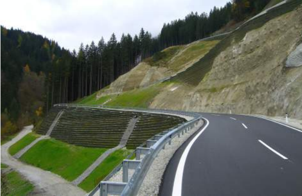
Abbildung 8 Teilansicht einiger der angeführten KBE-Böschungen
