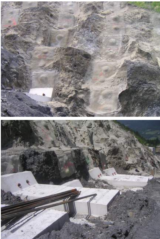
Abbildung 4 Maßnahmen zur Stabilisierung und Entwässerung des Ausschnittanges der Gründungsebene
