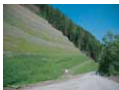
Vista della terra rinforzata dal piede
