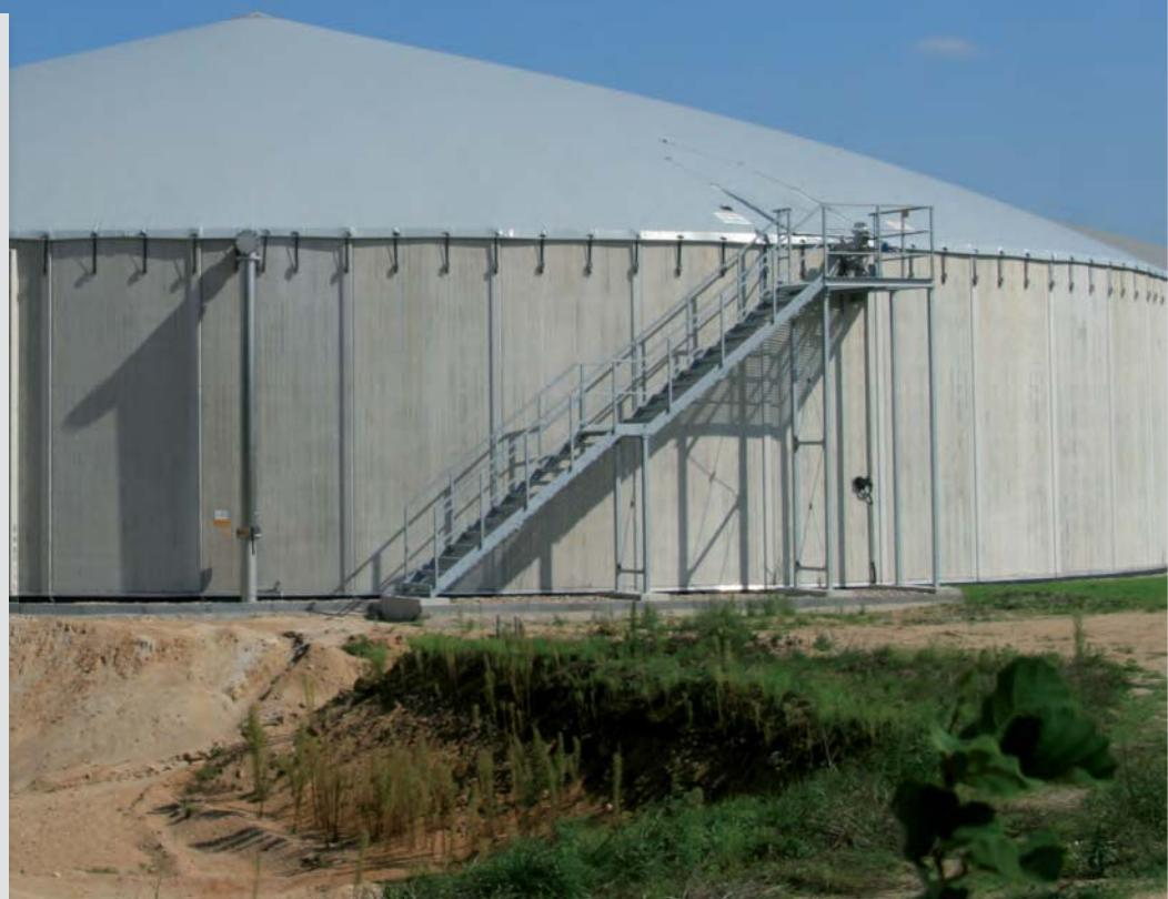
В стандартной комплектации используется однослойное покрытие, данное решение подходит для биогазовой установки, хранилища вторичной ферментации или емкости для сбора и утилизации остаточного газа с одновременной ликвидацией запаха. Герметизация осуществляется с внутренней стороны резервуара.
