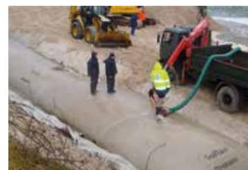
Заполнение технотубы (земснаряд, шламовый насос)
