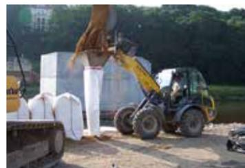
Механическое заполнение экскаватором через воронку
