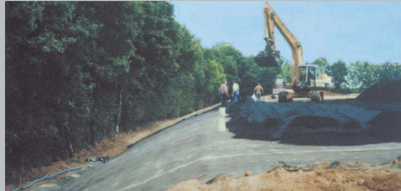
изоляция наружной поверхности свалки: **NaBento®**
