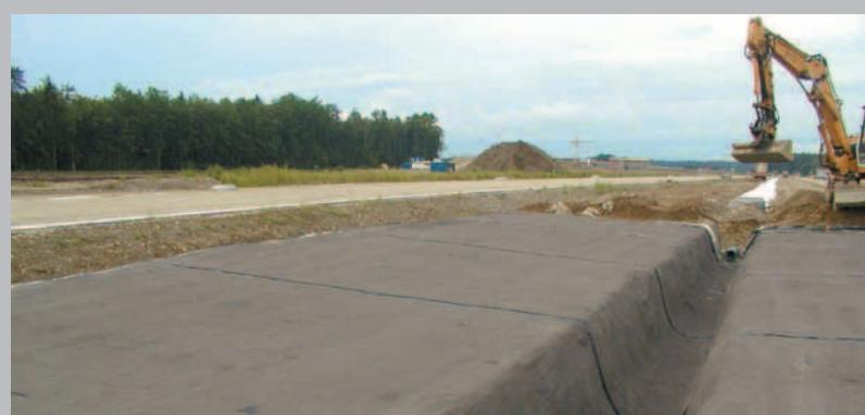
**NaBento®** для защиты грунтовых вод при строительстве дорог
