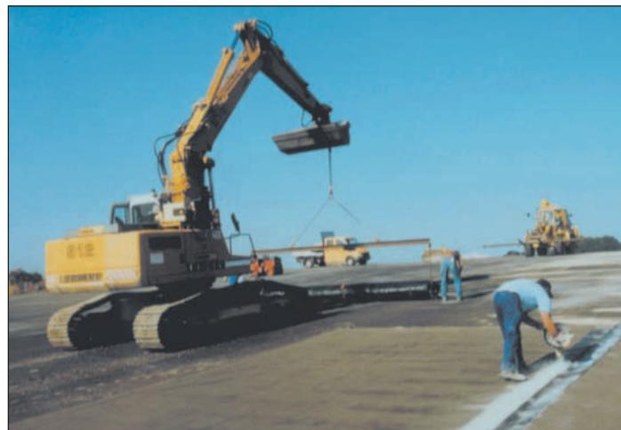
Использование **NaBento®** при строительстве свалок
