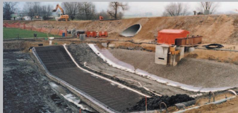
водоём для сбора дождевой воды: изоляция **NaBento®**
