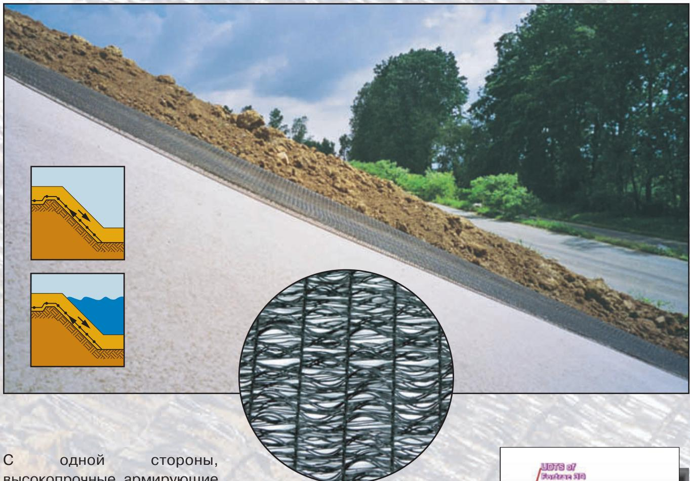
С одной стороны, высокопрочные армирующие георешетки Fortrac 3D® обеспечивают устойчивость против оползания по потенциальным поверхностям скольжения, как например, защитное покрытие свалок, берегоукрепление, защита скальных склонов от
