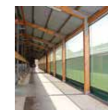
Lubratec Скручивающийся фронт с центральной приводной трубой с неподвижным приводом
