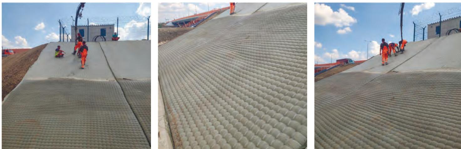
Наш инженерный отдел подготовил технологию укладки материала, с обязательным указанием дополнительного оборудования и материалов. Для крепления опалубки и откоса применяется стандартный анкер из арматурной стали А-I диаметром 12 мм; шаг анкерки - 1 м.
