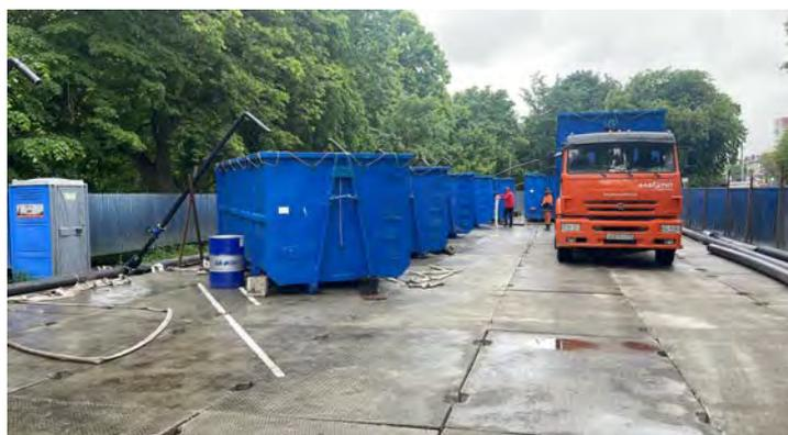
С помощью специальной трубы донные отложения попадают в контейнеры. Внутри смонтирована корзина, в которую помещается Фильтрбокс из плотной полимерной ткани. Донные отложения остаются внутри изделия, а лишняя вода через ткань отделяется, поступает в контейнер и через краны возвращается обратно в водоём.
