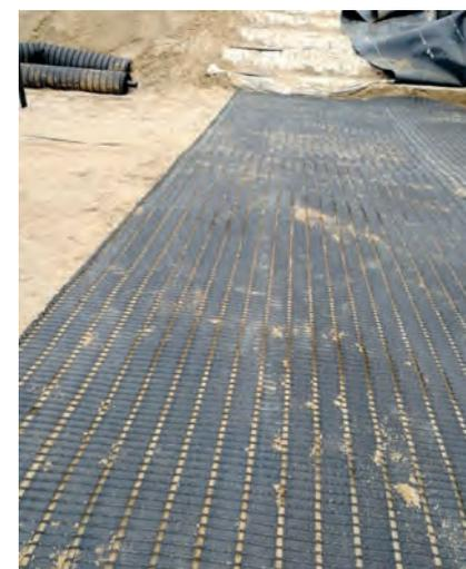
Рис.1 Конструкция свайного поля с гибким ростверком
