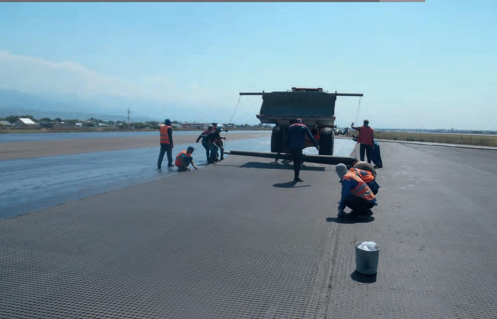
В 2017 году была выполнена реконструкция асфальтобетонного покрытия аэропорта г. Алматы. Проектом предусмотрено применение плоской армирующей георешетки из поливинилспиртового сырья (ПВС) фирмы HUESKER Synthetic GmbH. Применение данного типа геосинтетического обусловлено его уникальными характеристиками:
