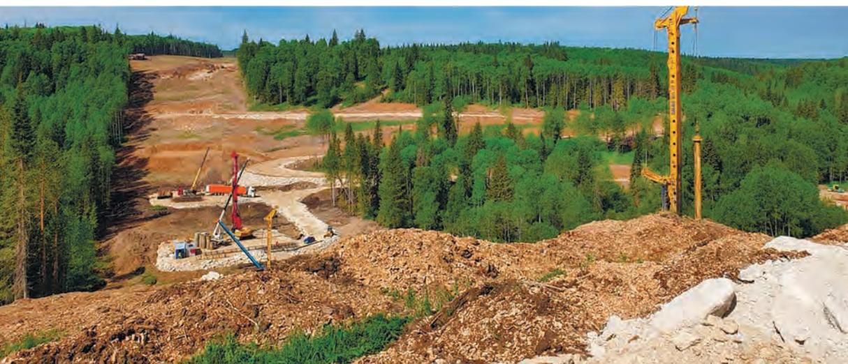
Система из вертикальных несущих элементов и гибкого ростверка была применена для укрепления грунтов основания подходной насыпи путепровода. Где, в качестве вертикальных несущих элементов применялись забивные ж/б сваи  $d=350$  мм.
