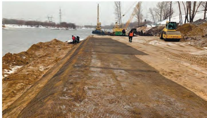
Высокая гибкость геосинтетического материала Fortrac объясняет его способность адаптироваться к неровным поверхностям, повторяя геометрию грунта. Все вышеизложенные преимущества сыграли ключевую роль при выборе типа георешеток.
