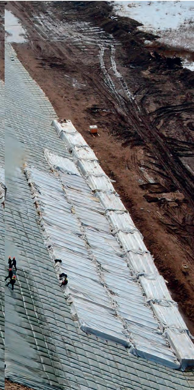
защиты откосов насыпи земляного полотна с помощью геосинтетической оболочки Incomat® Flex при отрицательных температурах, практически круглогодично. Использование данной технологии эффективнее с точки зрения производства работ и примерно на 20% экономичнее, чем традиционная укладка железобетонных плит. Кроме этого, откос, укрепленный заполненной бетоном геоболичкой Incomat®, выглядит эстетично и гармонично вписывается в окружающий ландшафт.
