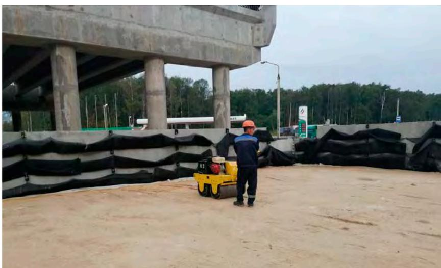
Расчеты, выполненные при участии инженеров фирмы ООО «Хюскер», показали, что требуются георешетки с кратковременной прочностью на разрыв от 110 до 150 кН/м. При этом шаг армирования принят равным высоте блока – 58 см. Длина заделки армирующего материала в тело насыпи определялась расчетом в различных поперечных сечениях, в зависимости от высоты насыпи.
