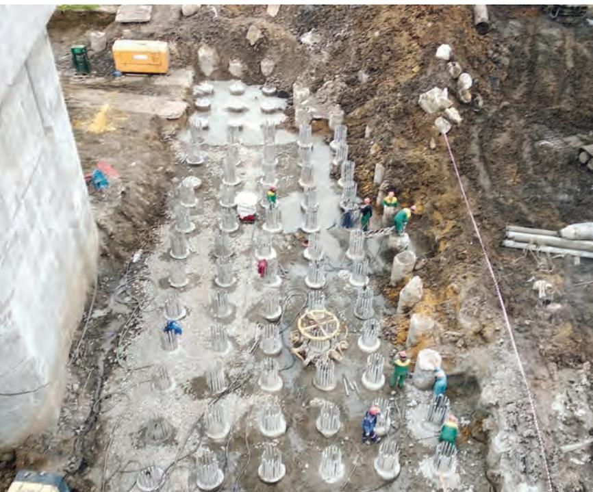
При проектировании земляного полотна автомобильной дороги были выявлены слабые грунты основания (глинистые грунты от мягкопластичной до текучепластичной консистенции) мощностью до 10.0 м на всем протяжении участка строительства, а также на подходах к устью моста через реку Москва.
