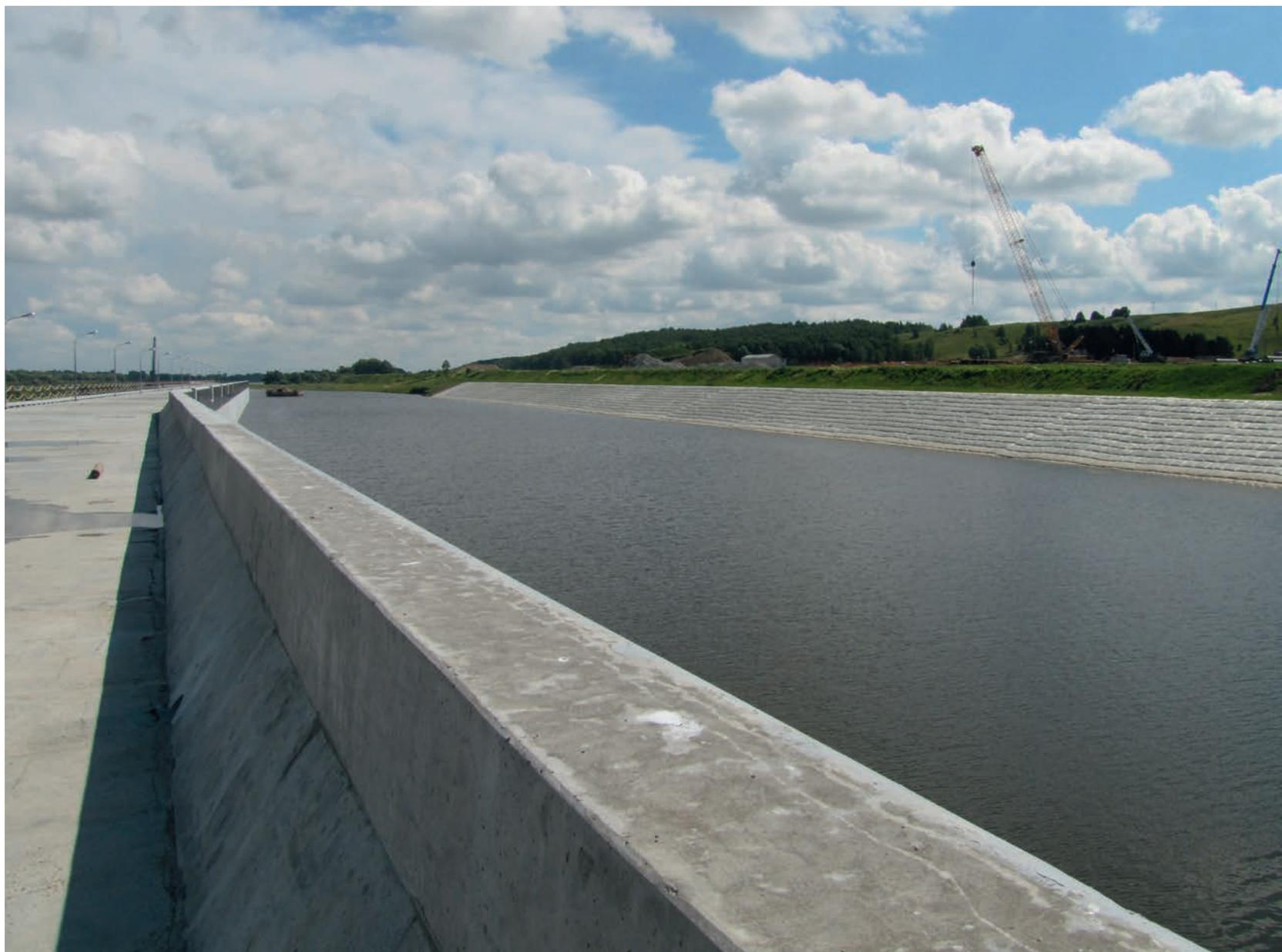
Также система бетонозаполняемых матов Incomat® применялась при укреплении откоса площадки административно-бытового комплекса (Общая площадь откоса около 10.000 кв.м), в качестве защитного мероприятия от возможного подтопления. Применение матов Incomat® было экономически эффективным решением для оптимизации проекта (после проведения технико-экономического сравнение с альтернативными вариантами по принципу «стоимость – скорость монтажа»).
