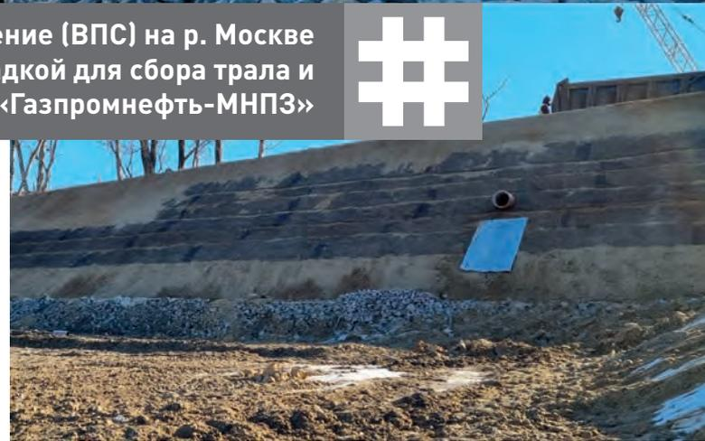
При строительстве временной дороги с углом заложения откоса 35 град, расположенной в пойменной части р.Москвы, генеральным проектировщиком было выдвинуто требование о необходимости возвести армогрунтовую конструкцию для обеспечения устойчивости грунтовой насыпи.
