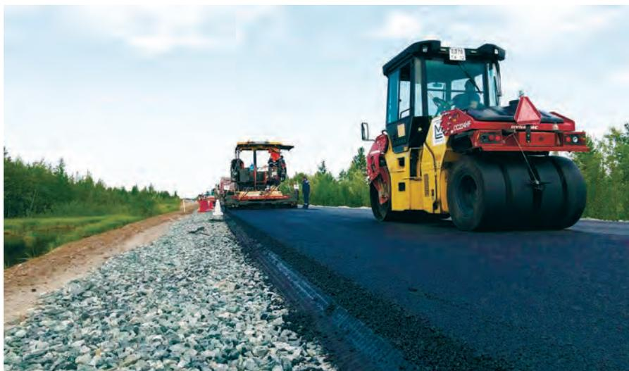
Данная технология и правильно подобранные материалы позволили использовать старые бетонные плиты. Армирующие свойства георешетки и подложки, пропитанных битумом, с позволяют замедлить образование отраженных трещин.
